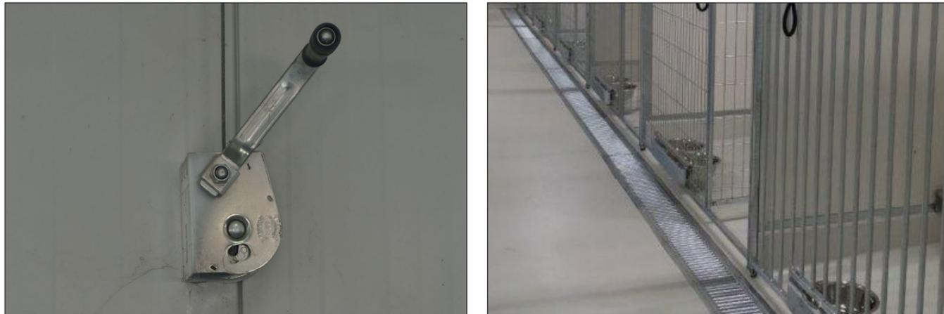
**Cerramientos de panel sándwich** (chapa-poliuretano-chapa) de 40 mm. de espesor, con ventanas batientes de cristal doble o posibilidad de ventanas de policarbonato de 8 mm, de **apertura de guillotina centralizada** a través de tornos manuales.
